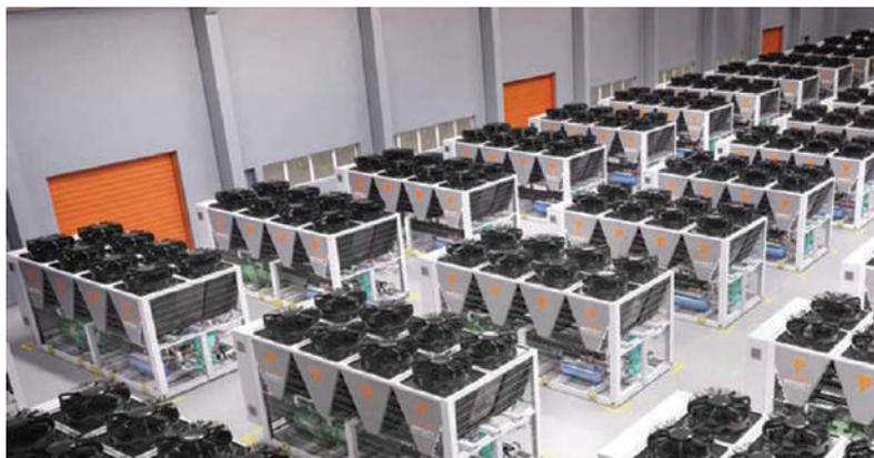
энергoeffективные решения. К ним относится представленная компанией Antarcctis система адiabатического косвенного охлаждения на основе композитного трубчатого теплообменника (подробнее об этой системе – в статье «Охлаждение для ЦОДа: обойдемся без компрессоров?», «ИКС» № 3'2022, с. 30).
