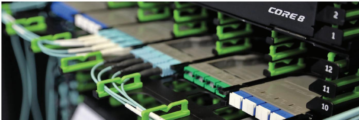
Порты подключения активного оборудования расположены в одной половине шкафа главной зоны распределения, порты подключения серверов – в другой. В пределах этой стойки кросс-коммутации проводится соединение нужных портов. В центральном кроссе есть необходимые зоновые панели разных номинаций и претерминированные решения в виде кассет и патч-кордов.
